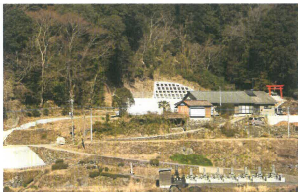
保全対象全景
