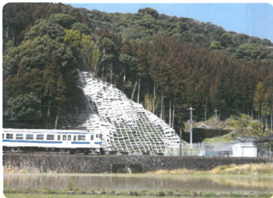
保全対象全景
